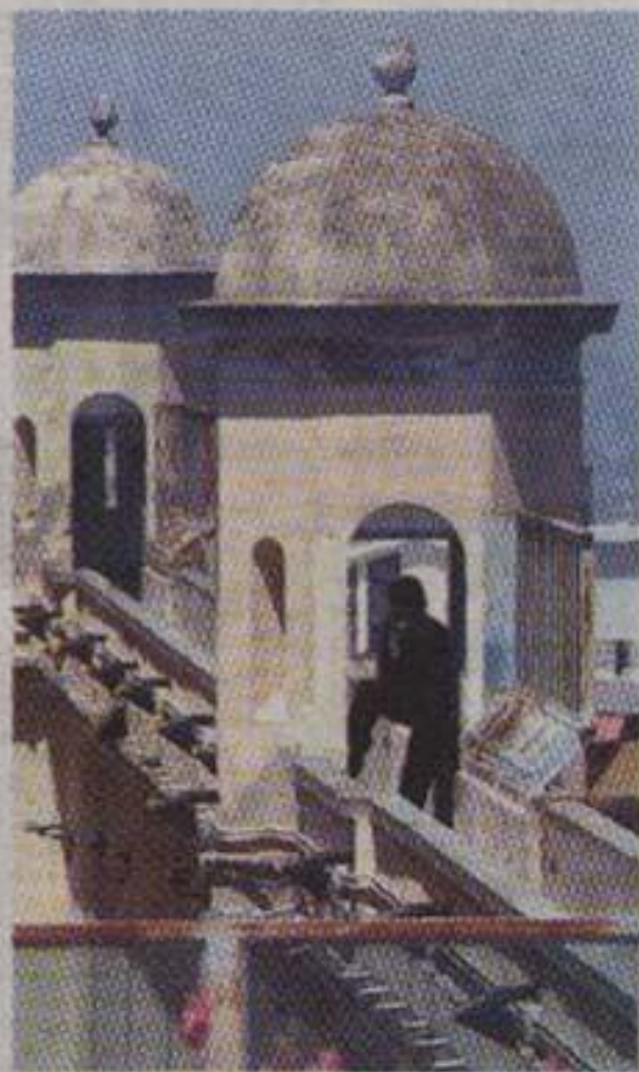
turno di guardia nel muro di cinta del carcere di Buoncammino
